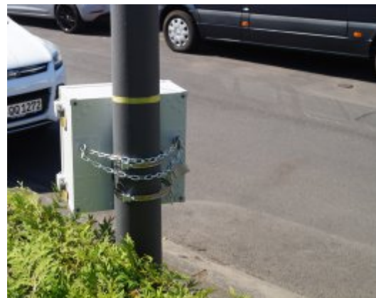
Impactor zur Gegenrichtung mit beiden Vorhängeschlösser abgeschlossen fertig Montiert.
