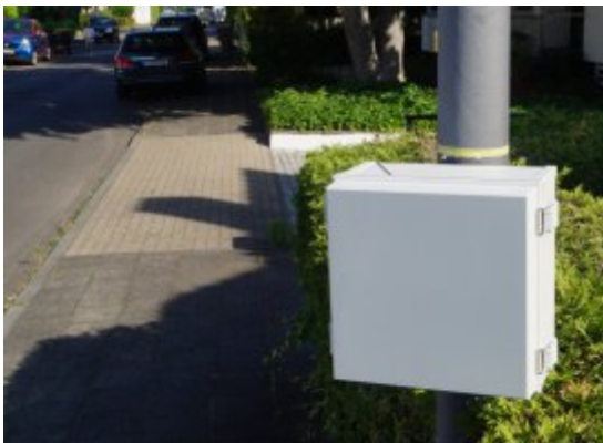
Impactor zur Messrichtung zeigen und an der Straße ausgerichtet.
